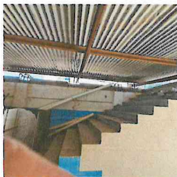
Foto 3: Sustitución de lámina acanalada, se encuentra en mal estado y de una manera inadecuada
